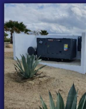
**Planta en emergencia de 30 kw en operación automática a diesel en Bouchis café.**
