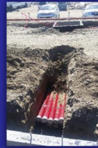
Trabajos de infraestructura consistentes en construcción de bancos de ductos de media tensión e instalación de seccionadores.
