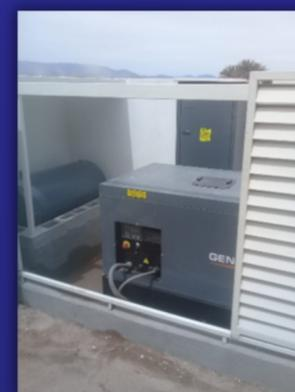
**Planta de emergencia de 30 kw en operación automática a diesel en cárcamo de bombeo 2.**
