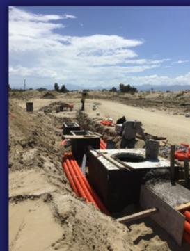
Trabajos de infraestructura consistentes en construcción de bancos de ductos de media tensión e instalación de seccionadores.
