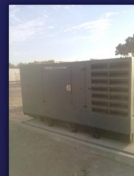
Planta en emergencia de 125 kw en operación automática a diesel en area de servicios.
