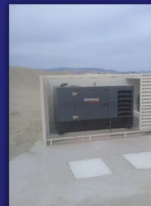
**Planta en emergencia de 45 kw en operación automática a diesel en cárcamo de bombeo maestro 1.**
